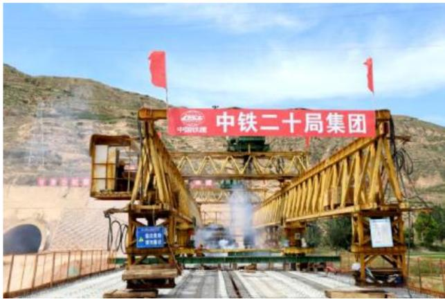
6月5日,集团公司承建的陇漳高速公路项目关键节点工程菜子河大桥,双线共196片预制箱梁全部架设完毕,标志着该项目架梁工作进入全面冲刺阶段。图为菜子河大桥架梁架设现场。邵小玲 摄
