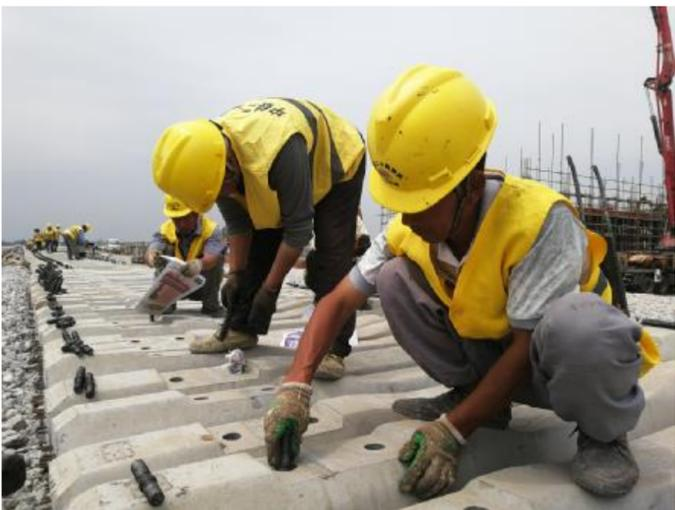
近日,四公司马鞍山浦港铁路项目部开展的“自豪、自信、自觉,大千90天”劳动竞赛进入决胜阶段,项目部全体员工充分发扬团队精神,全面推进安全、质量、进度、效益管理,以确保今年7月份正式通车。图为施工人员进行铁排钉联作业。 林向军 摄
