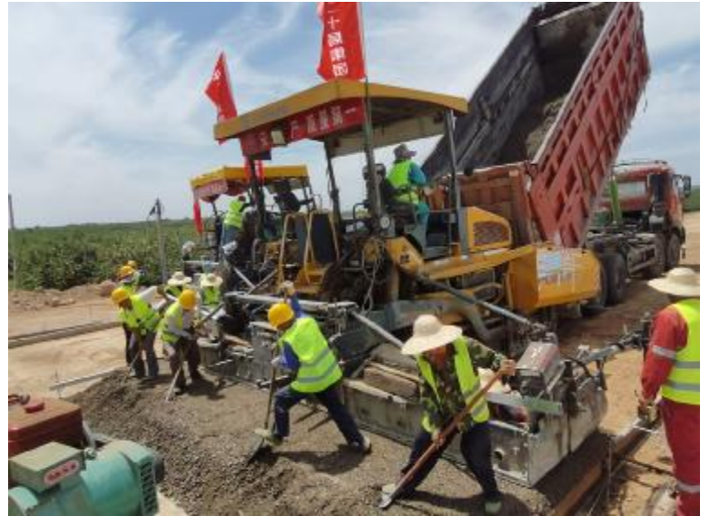
图为水稳基层铺设施工
