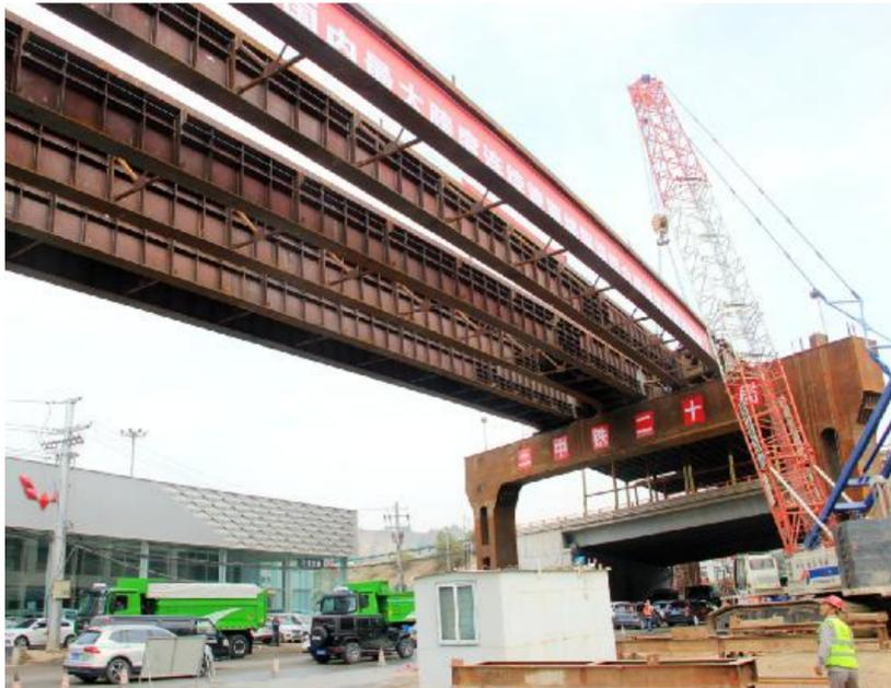
7月5日9时15分,两台大吨位国产吊车将自重110吨的钢梁平稳吊装到109国道兰州段改扩建工程既定的墩台盖梁上。至此,由市政公司承建的我国最大跨度连续管翼缘钢混组合桥跨连霍高速公路梁桥架设完工。该钢梁桥是兰州老城区通往兰州新区快速干道高架桥的重要组成部分,分三跨式布设,全长163米,桥面宽17.5米,最大跨度61米,为我国同类型梁桥跨度之最。图为架梁现场。
