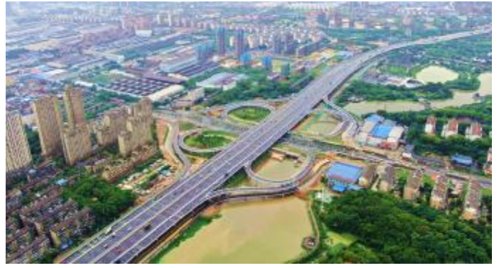
7月1日上午,由一公司承建的南昌市昌南大道快速路迎宾大道互通立交顺利通车。同时开通的还有抚生南路、迎宾互通5条匝道和南莲互通10条匝道。至此,红色革命城南昌正式进入二环大交通时代,对完善南昌市干线路网结构、发展社会经济有着十分重要的意义。图为“首蓂叶”式设计的昌南大道快速路迎宾大道互通立交工程。康秧秧 摄
