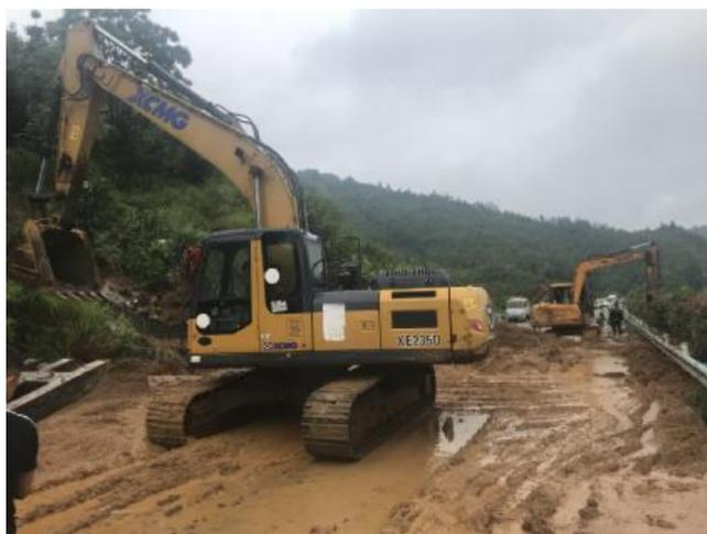
受持续降雨影响,6月24日凌晨3时30分,位于贵州省安顺市紫云县境内的安紫高速公路两处边坡塌方,塌落下来的石块、泥土和杂树占据了大半幅路面。接到通知后,中铁贵州公司安紫高速养护项目部立即启动防汛抗洪抢险应急预案,迅速调拨3台挖掘机、12辆自卸车、近20名工人到达现场展开清理和救援工作。经过近19个小时紧张有序抢险,高速公路于22时30分恢复正常通行,车辆安全有序通过。图为抢险现场。
