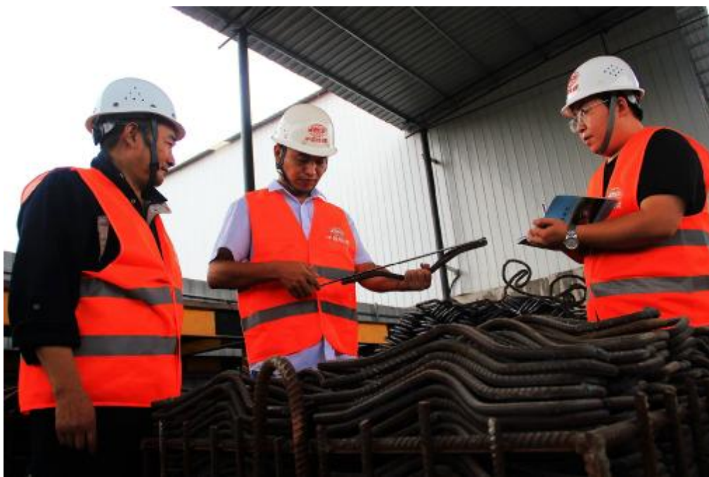
市政公司重庆铁路枢纽东环线项目部以标准严控过程,以过程铸造精品,让标准成为习惯,让习惯成为标准,确保各单项工程一次成优。图为9月5日工程质检人员抽查钢筋加工质量。
