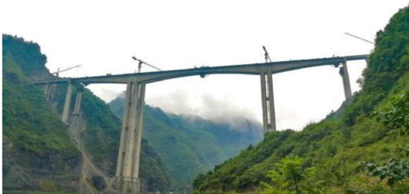
9月12日,四公司承建的石黔高速公路最高连续刚构桥——郁江河特大桥右幅顺利实现贯通。该特大桥全长589米,为双线连续刚构桥,集深基、群桩、高墩、大跨于一身,最大跨径200米,最大墩高149米,是全线控制性重难点工程。图为已合龙的郁江河特大桥。 马川摄
