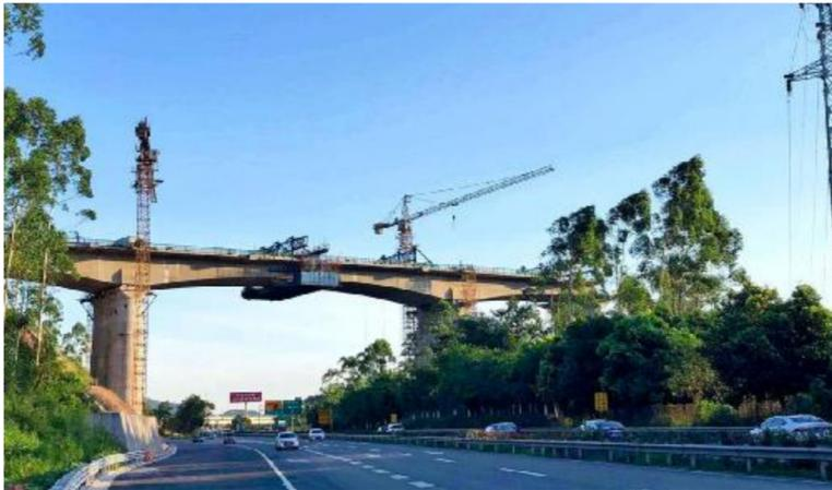
渝黔高速三线特大桥全长591.57米,是重庆铁路枢纽东环线项目重难点控制性工程之一。该桥所处位置地质非常复杂,且靠近重庆市巴南区收费站,车流密度大,施工安全风险高、难度大。在跨高速连续梁施工中,项目采用全封闭式挂篮法悬臂浇筑施工,将高空作业施工转换为在与外界隔绝的封闭操作空间中进行,使连续梁施工始终处于安全可控状态,确保了精确合龙。
