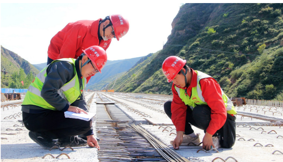
近日,甘肃省重点工程陇漳高速公路全线21座大中桥梁全面进入上部结构施工。担负第二标段施工重任的市政公司践行“品质铁建”理念,以工艺保工序、以工序保质量推进样板引路,促进提品质、创品牌常态化。图为技术人员在木林汪家河特大桥检测梁体钢筋搭接尺寸。 许岗 摄
