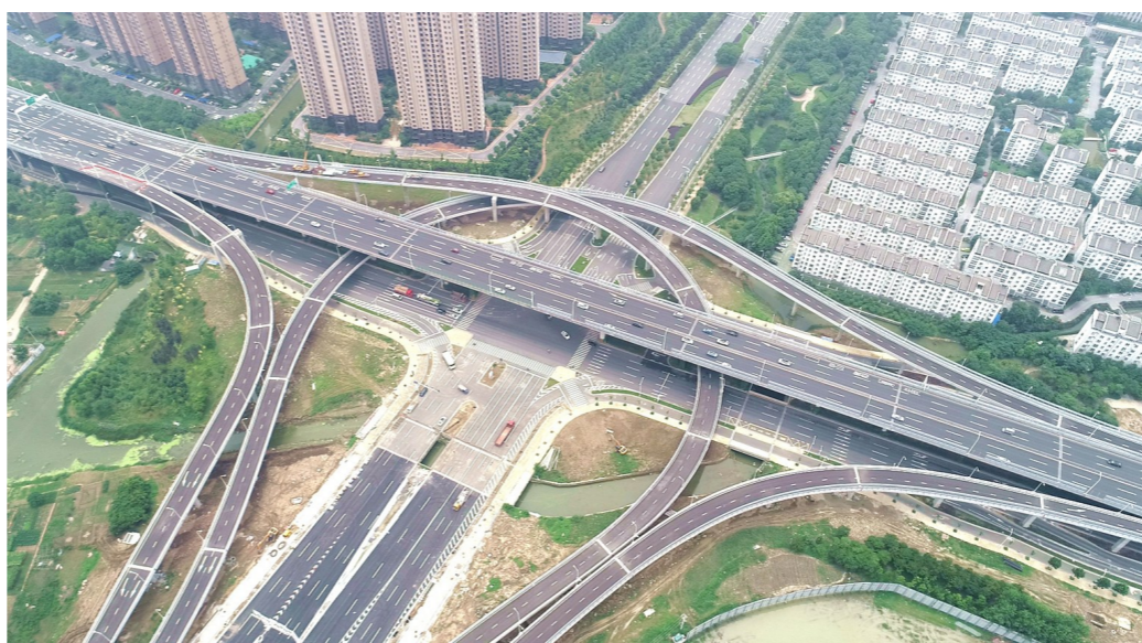
日前,一公司承建的常合高速公路项目进入桥面铺装浇筑。施工过程中,建设者创新开发了贝雷梁与地面桥盖梁相组合、低净空随车吊吊装、无拉杆钢模板等新工艺,为项目建成通车奠定了坚实基础。该项目团队连续四年荣获省市“交通工程建设先进集体”,同步实现了滚动发展。图为建成通车的常合高速公路项目三环互通立交。 谢建辉 摄
