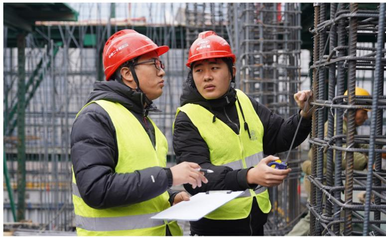
日前,面对气温低、工期紧、作业面多、大体积混凝土浇筑频繁等困难,六公司在第十四届全运会配套工程——西安绿地丝路全球文化中心165米超高层主楼施工中,大力推行“楼长巡检制”,选拔施工经验丰富的技术人员担任“楼长”,对施工现场各个环节进行质量巡检,确保冬季施工质量全面可控。图为7号楼“楼长”徐海圣(左)正在和现场技术员检查钢筋绑扎质量。
