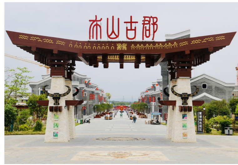
日前,由中铁贵州公司承建的广西贵港覃塘中央文化大街东、西侧商业楼项目已竣工,商家陆续进驻并开始营业。该项目成功构建了一个集休闲、古风、生态于一体的网红打卡地,为当地全域旅游建设添上了浓墨重彩的一笔。图为布山古郡全景。徐 摄
