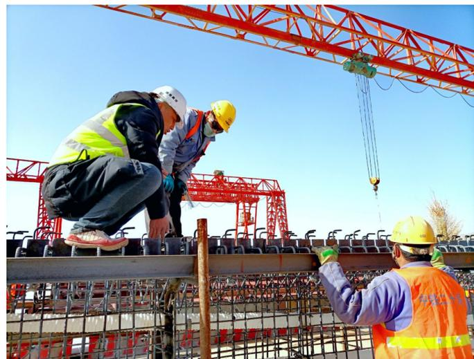
近日,在四公司承建的宁夏吴忠市同心县境内银昆高速LJ03标段施工现场,全体参建人员上紧发条,铆足干劲,掀起复工大干高潮,路基、桥涵、通道等工序全面有序推进。图为现场负责人在检查T梁钢筋制作工艺。
