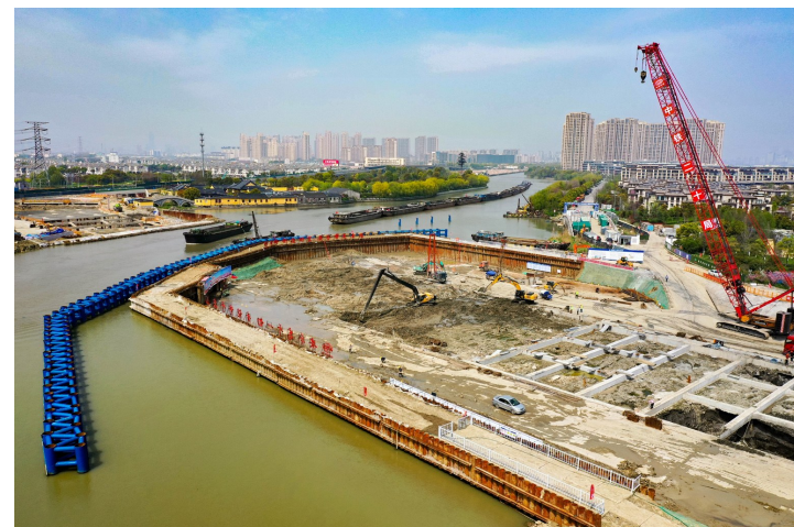
苏州独墅湖项目施工现场美成一幅画
