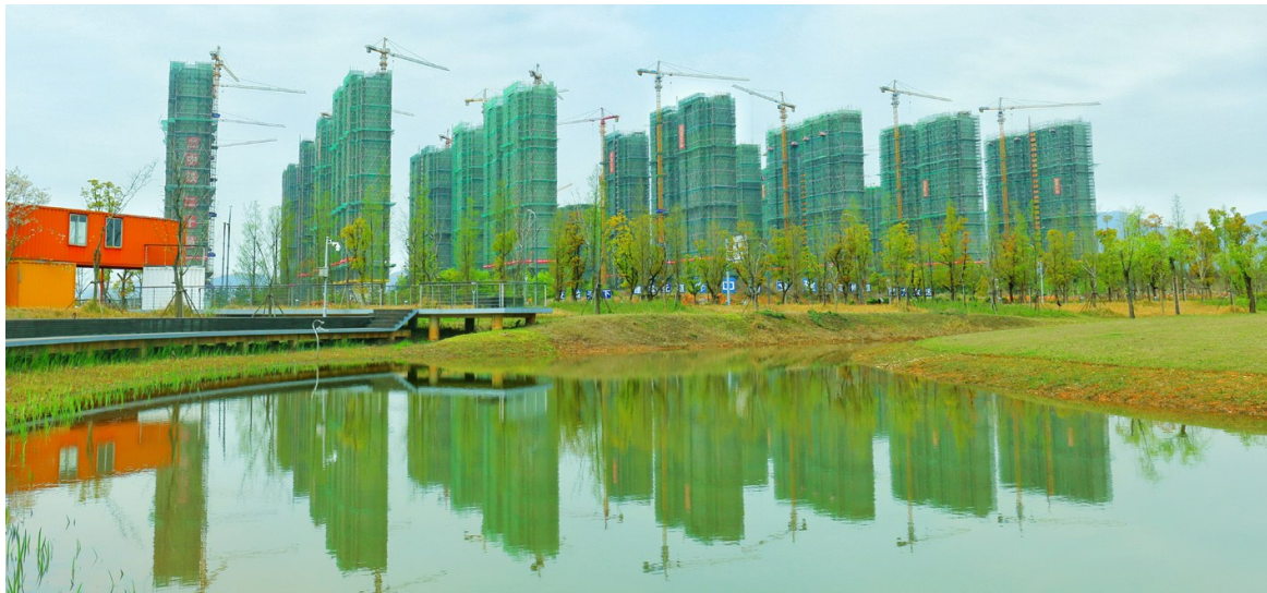
近日，三公司南昌梦庐花园房建项目E地块10、11、12号主楼顺利实现封顶，圆满完成既定节点目标，至此，该项目开累已实现19栋主楼封顶。自上场以来，项目部坚持抓质量、保安全，控工期、强管理，确保了项目平稳、优质、高效运转，目前正陆续展开砌体、二次结构及外墙保温等工作。图为三公司南昌梦庐花园项目E地块施工全景。徐鑫摄
