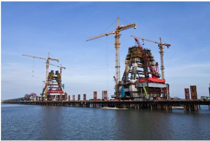
三公司北海西村港跨海大桥项目部自上场以来,便以推进科技攻关为导向,以质量管理为重点,以标准化、精细化、规范化管理为手段,邀请国内经验丰富的专家到项目帮扶指导。经过全体参建人员的共同努力,他们先后攻克了超长桩基施工控制、大体积承台施工高性能C40砼施工温控防裂等多项技术难题。截止6月底,该项目已完成产值85%,安全、质量、进度全面受控。
