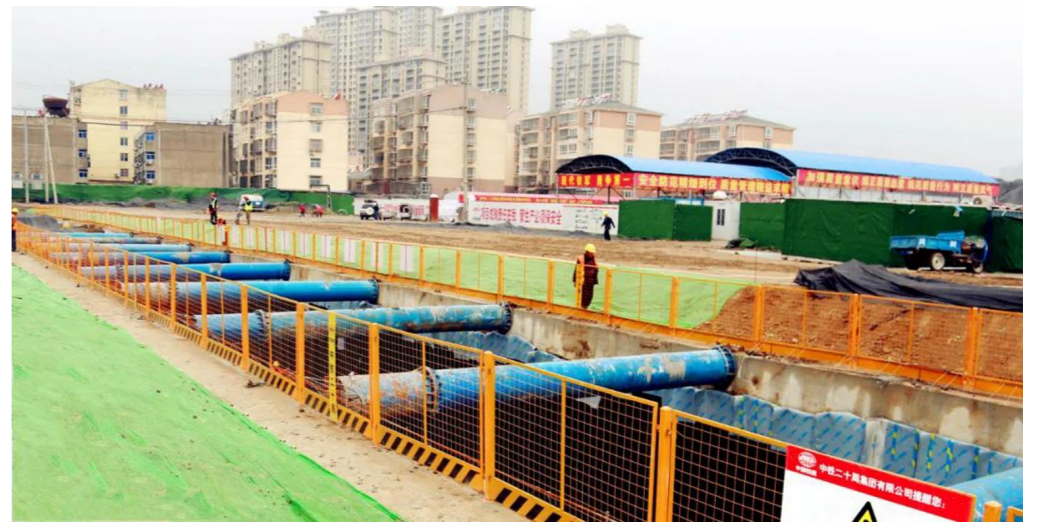
标准化施工现场
