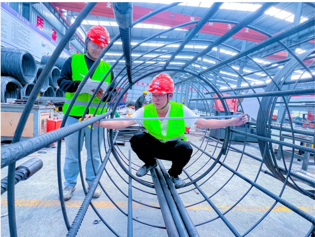
近日，一公司苏台高速公路项目部抢抓施工黄金季节，锚定节点目标，不断掀起施工大干高潮，安全、质量、进度受到业主的高度好评。图为工程技术人员在检查钢筋笼质量。张宛珈 摄
