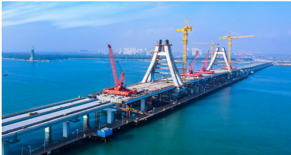
由三公司承建的广西北海市西村港跨海大桥全长2544米,跨海桥梁总长1776米,设计为双向6车道,主塔采用国内罕见大倾角空间索塔,造型来源于北海市出土的西汉文物铜风灯,铜风造型的巧塔配以如同弦琴的拉索,主桥凸显“风冠琴韵”,独具魅力,为全国首创。图为11月15日,建设者正在进行钢架架设施工。 陈福得 摄
