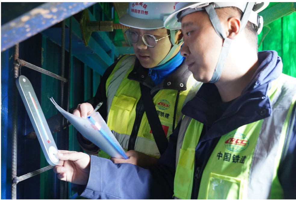
连日来，地处黄土高原的二公司西延铁路项目受寒潮影响，气温低至零下10度。为保证桥梁冬季施工质量，建设者为桥墩搭建新型保温棚架，外侧采用阻燃、保温的聚氨酯材料，内里选择热风机与蒸汽发生器相互搭配，桥墩好比穿上了新潮“智能温控羽绒服”，即使极端天气侵袭，棚架内部温度也能维持在15℃以上。图为技术员在检查棚架内施工温度。陶柯宇 摄
