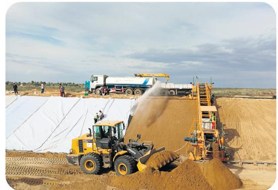
图为乌兹别克斯坦渠道项目边坡养护施工现场
