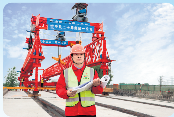
图为邢小雷在施工现场进行三维激光摊铺技术研究
