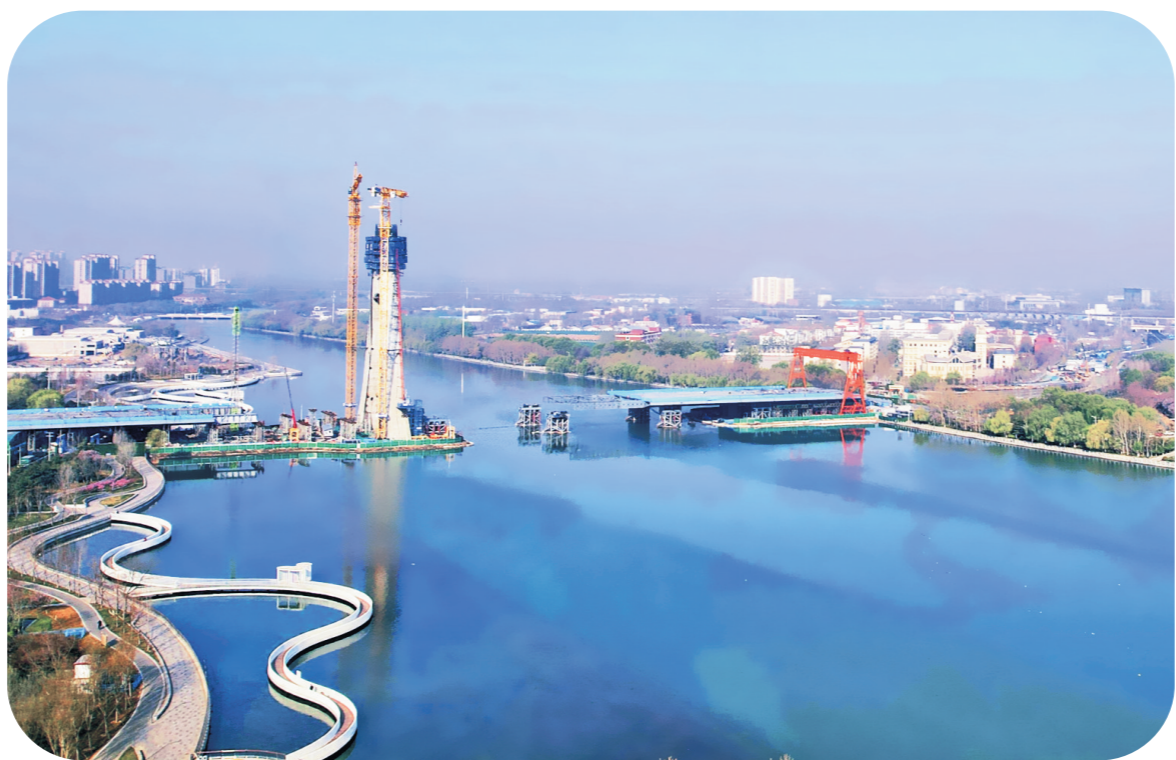
连日来,为避免钢平台对河道的破坏,六公司石家庄太平河桥项目践行“绿水青山就是金山银山”的理念,采用钢箱梁顶推技术,在水中临时支墩,并创新应用无支架法移动平台施工,同时采用预制块筑岛围堰工艺,保护了太平河一江碧水,保障了河道正常通航。图为太平河桥施工现场。曹冰雷 摄
