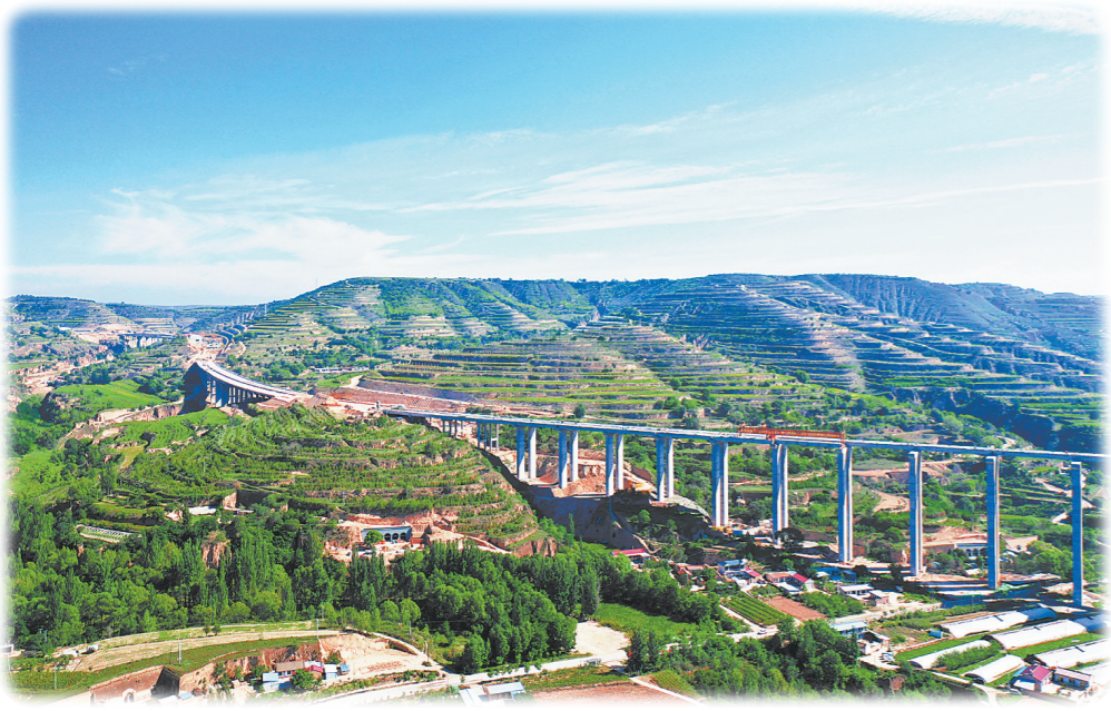
图为正在建设中的银昆高速公路友联红河特大桥
