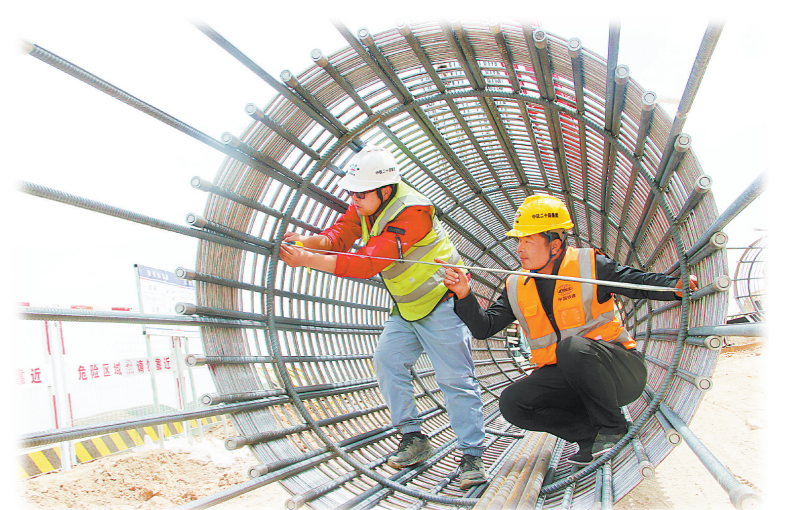
图为工人在自查友联红河特大桥钢筋加工质量 黄梦凡 摄
