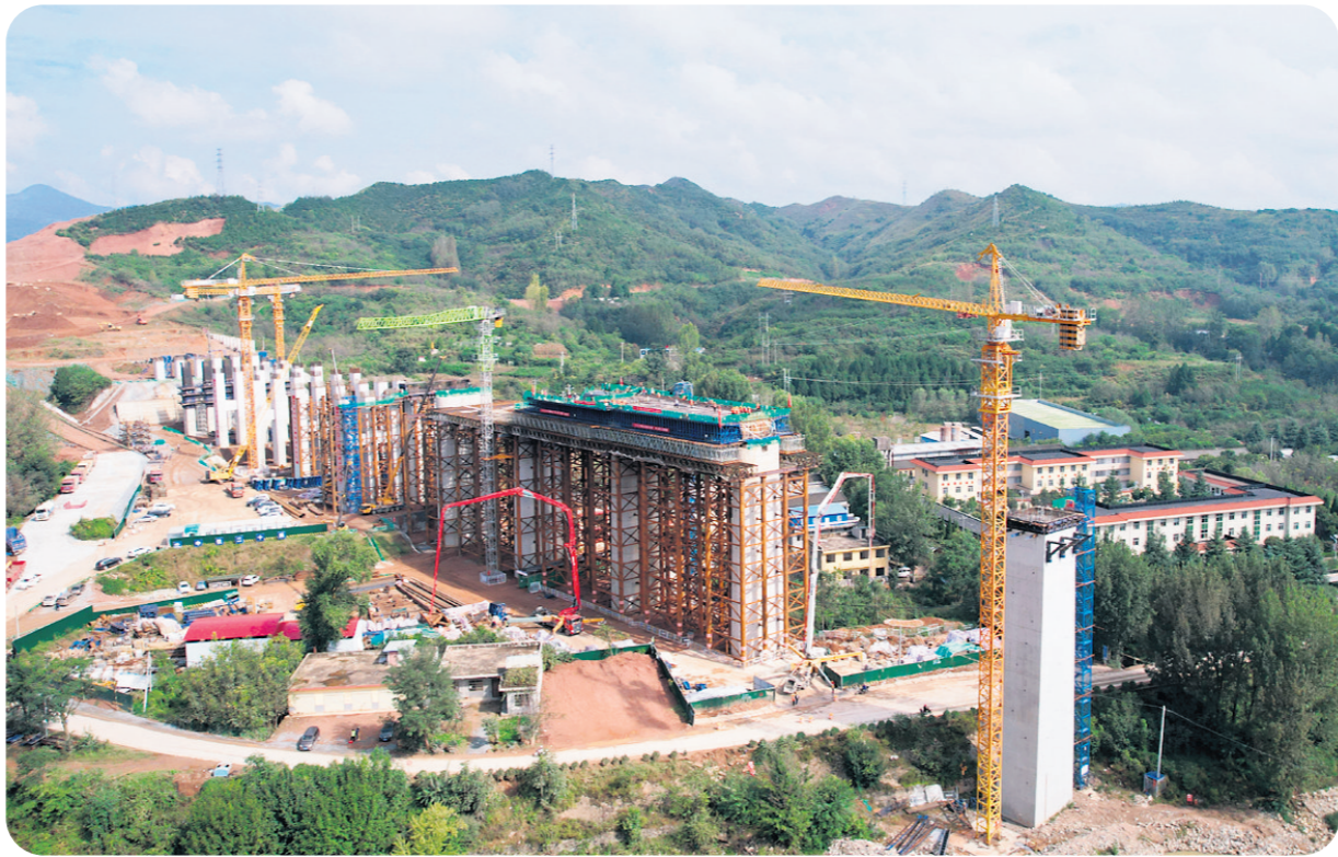
9月21日，随着四公司建设者将最后一立方混凝土注入桥梁模内，西十高铁4标南秦河特大桥首片梁浇筑顺利完工。该桥全长895.8米，最大墩高37米。施工中，项目建设者采取封闭管理措施，明确安全质量控制要点以及安全防范等措施，确保了浇筑作业顺利完成，为后续加快施工提供了有利条件。图为南秦河特大桥首片梁浇筑现场。刘坤仑 摄
