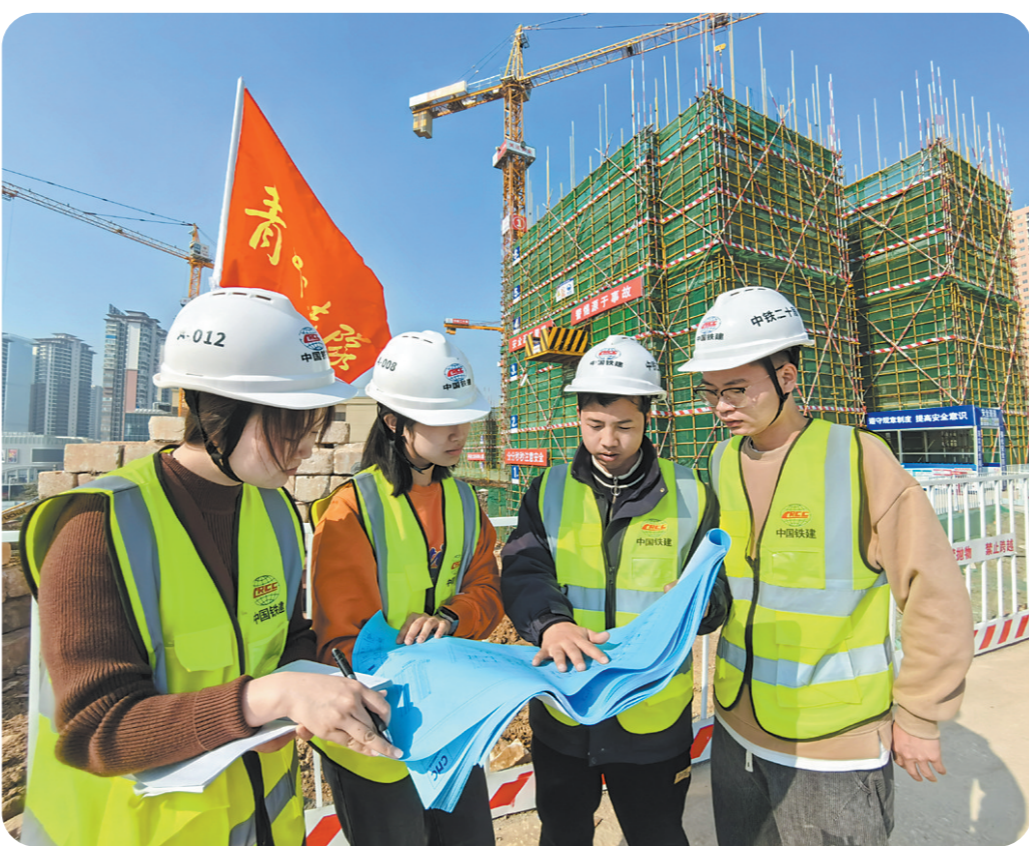
近日,五公司南宁轨道云启项目抢抓施工黄金季,掀起大干高潮。为了激发团员青年的积极性,该项目成立了青年突击队,通过技术攻关、工程量复核等形式,激励团员青年当先锋、做表率,优质高效地完成项目建设任务。图为项目青年突击队员在施工现场讨论技术方案。 徐彬摄
