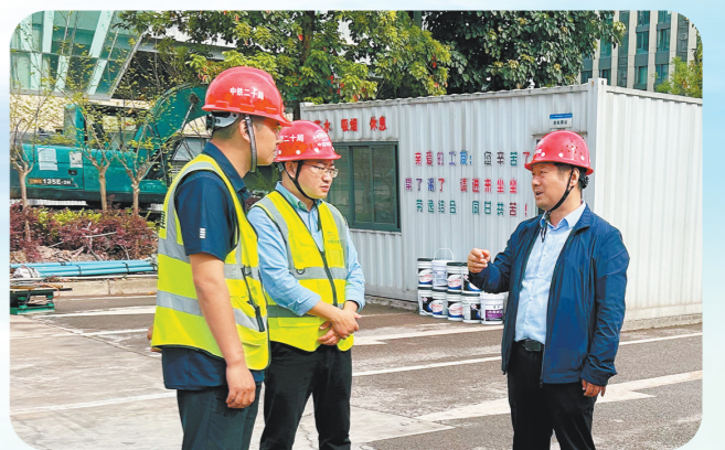
图为任高峰(右)在施工现场进行技术指导
